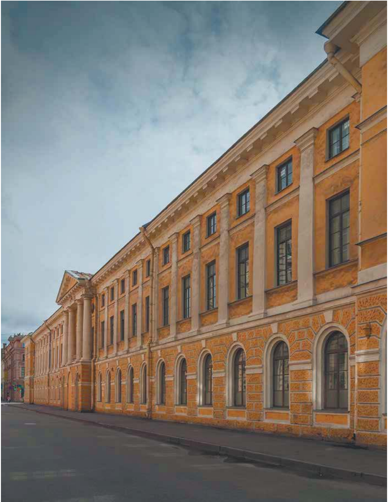
Почтамт. Фасад с Почтамтского пер.
