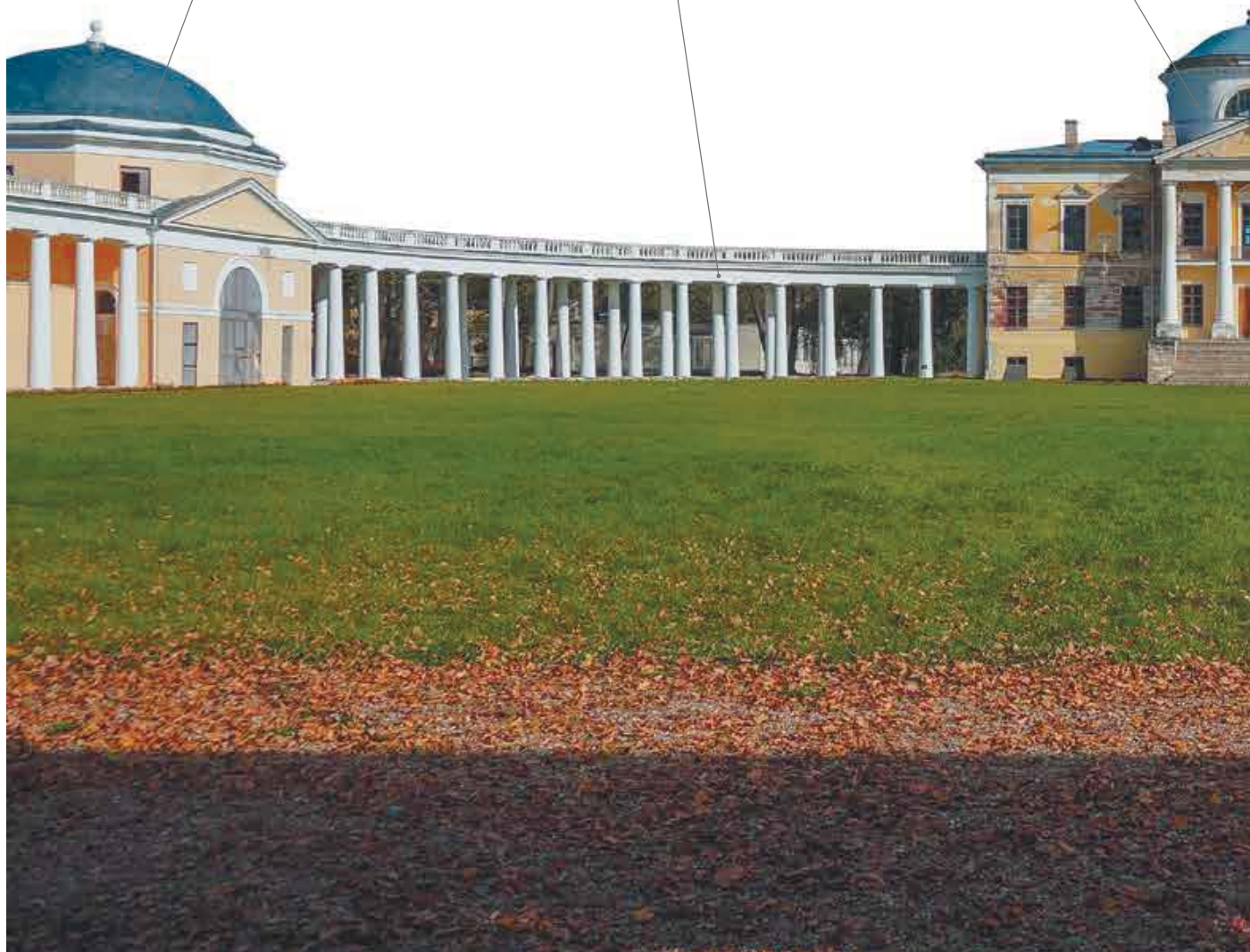
Дом в усадьбе Знаменское-Раёк. Вид с парадного двора
