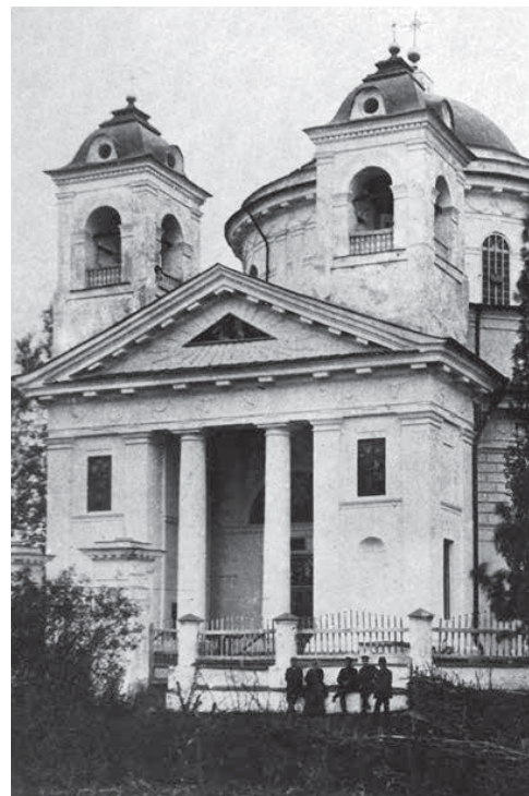
Церковь Рождества Христова в селе Вергуны. Вид с запада. Украина. Фото 1900-х гг.
