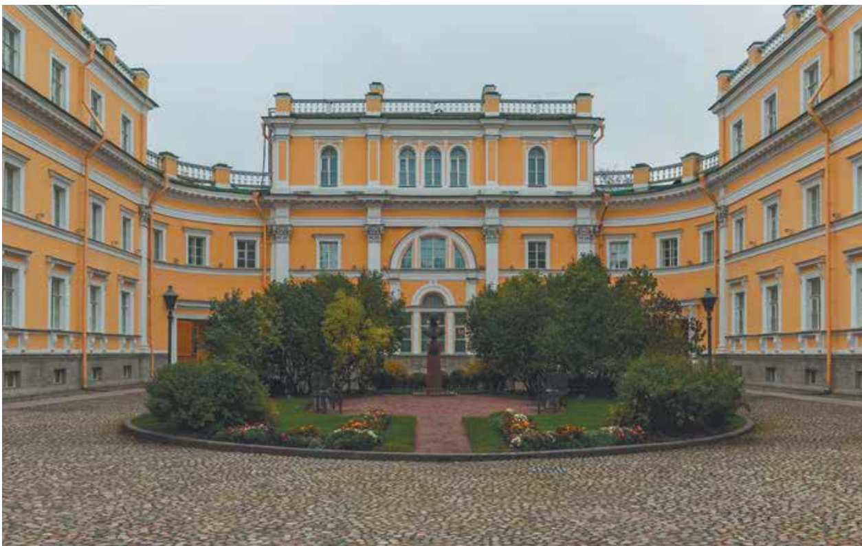
Дом Г. Р. Державина на ул. Фонтанка. Дворовый фасад. Санкт-Петербург, Россия
