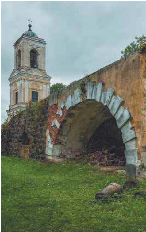
Церковь Троицы в усадьбе Прямухино. Пандус и колокольня
